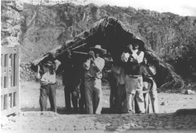
Foto 2. Niño trabajando con adultos en la construcción de una casa.
